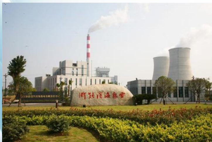
浙能绍兴滨海电厂
