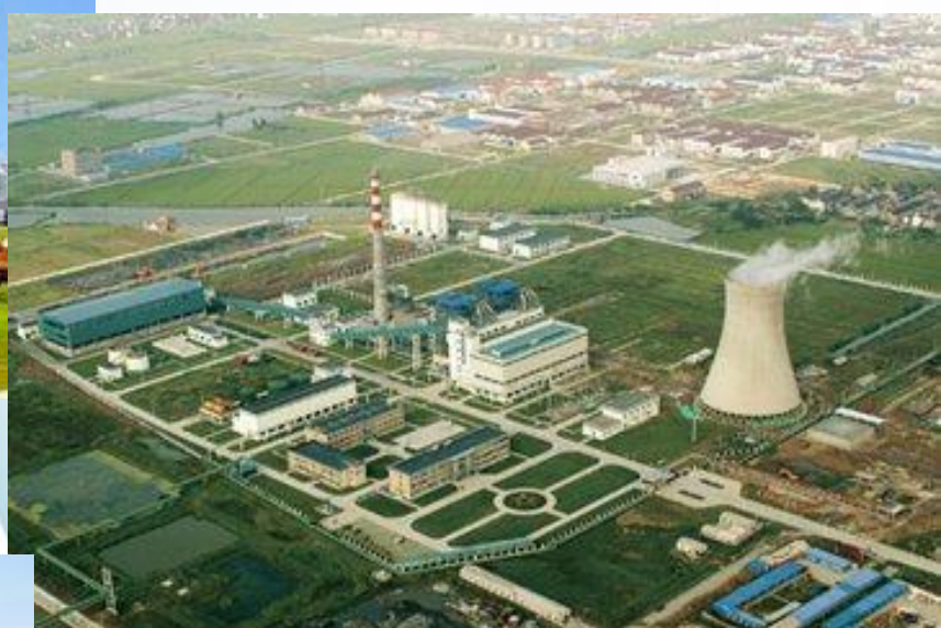
无锡西区电厂
